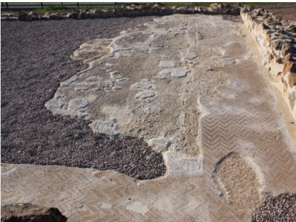
Fig. 5: Aspecto final do tratamento de pavimento em opus tessellatum
